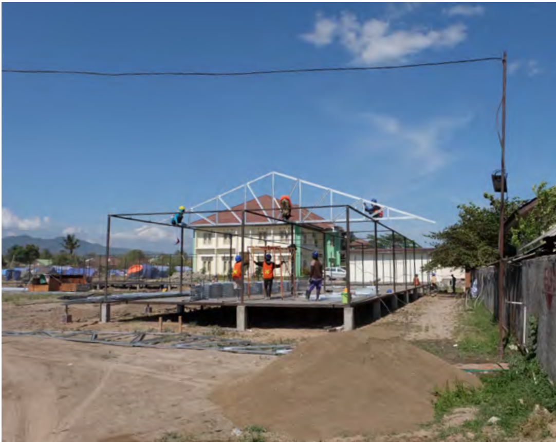
Pembangunan Bangunan Sementara Kantor Pemerintahan.
