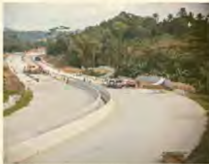
JALAN TOL: Jalanan Proyek Pembangunan Rute Jalan Tol Balikpapan-Samarinda (BKS) Sebelah Utara dan 13,5 Kilopanis di Balikpapan, Kalimantan Timur, Jumat (20/10). Pembangunan Rute Jalan Tol Balikpapan-Samarinda bagian dari Proyek Strategis Nasional (PSN) yang sedang berlangsung sejak bulan April 2019.
